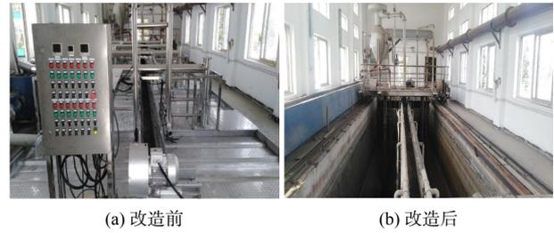
图6 曝气沉砂池改造前后对比
