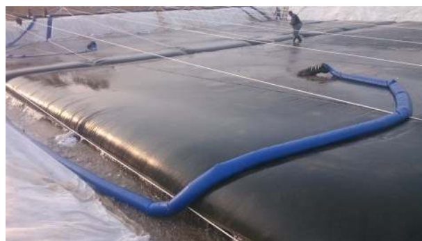
图5 土工管袋充填效果现场图
